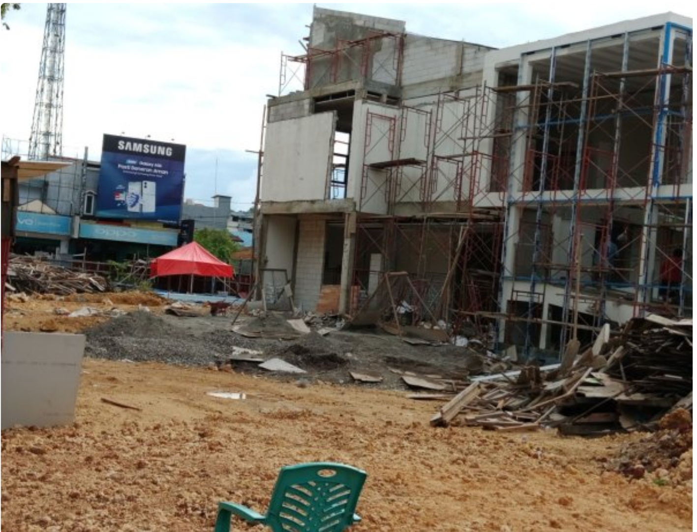
Proyek Pusat Layanan Usaha Terpadu (PLUT) Kota Baubau Melewati Masa Waktu Pekerjaan, Senin (06/01/2025)
